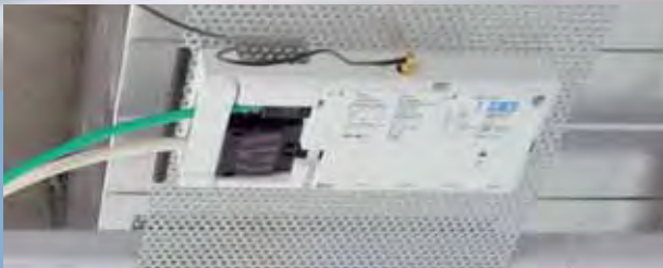
Bild oben: Wieland gesis RC EIB/KNX Gateway mit externer Antenne im Deckenhohraum
